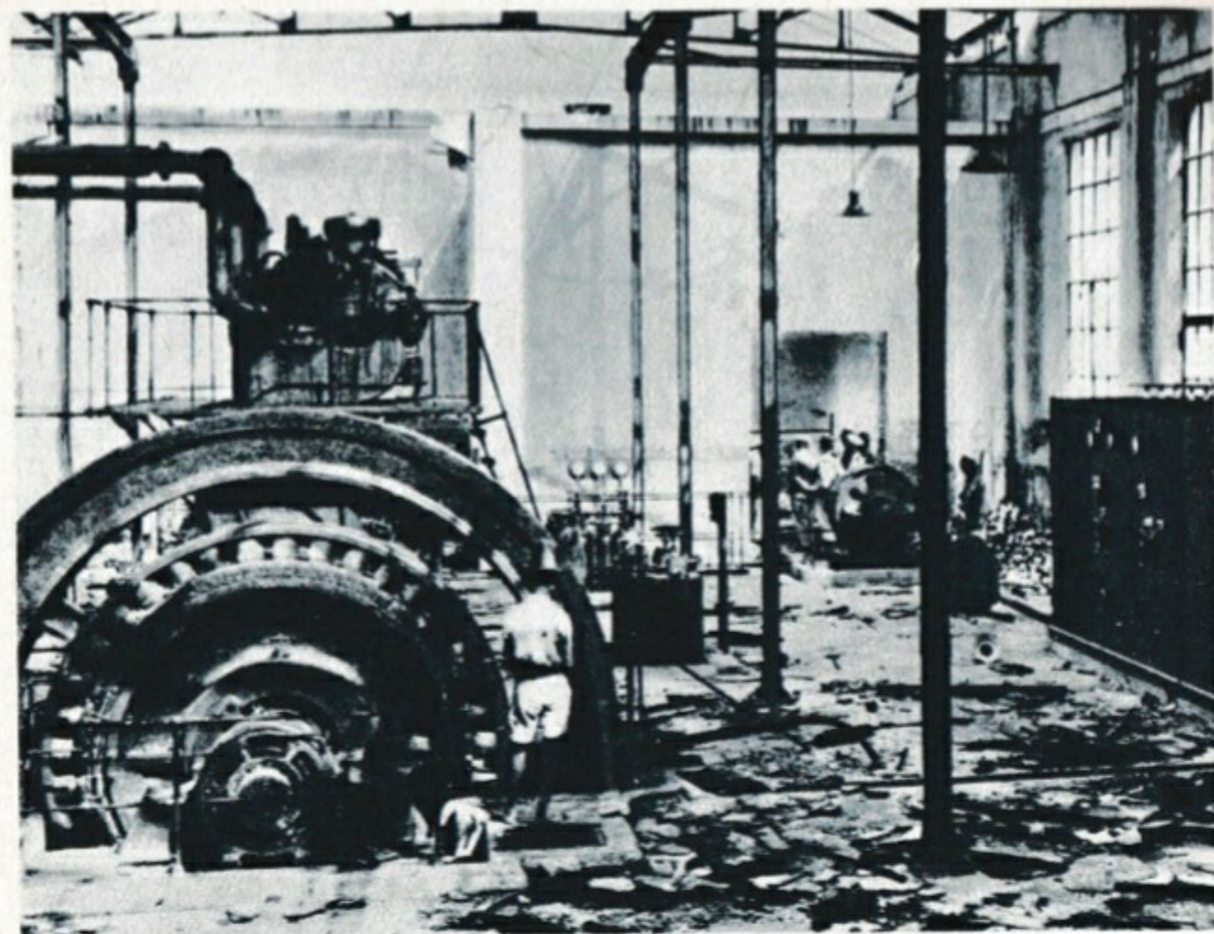
Fig. 59 - La centrale elettrica di Ordio devastata dai ribelli
