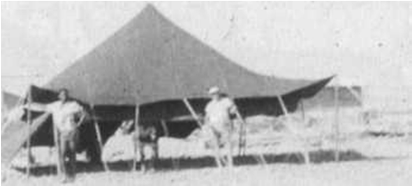
Foto 16: Ras Endarge, montaggio tende
